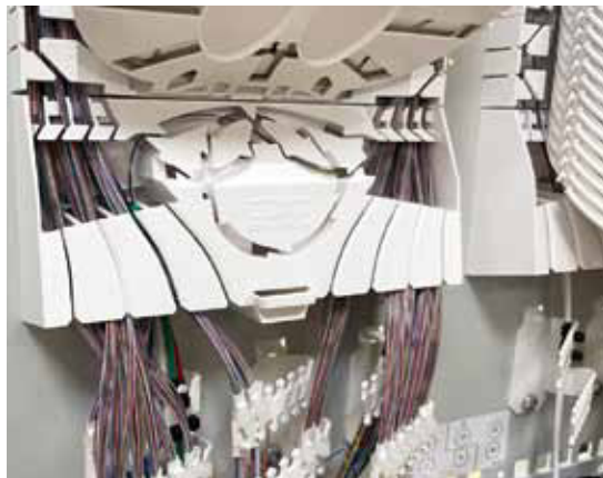
Das CCM Spleißrack in der PoP-Station kann 4700 Einzelfaser-Spleiße oder 12000 Spleiße mit Spider Web Ribbon-Fasern aufnehmen.
